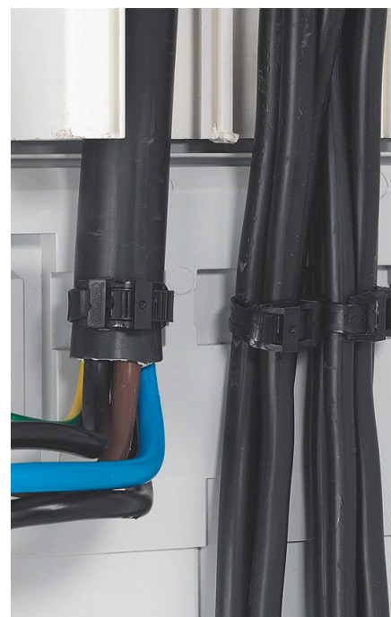
Arrimage des câbles
