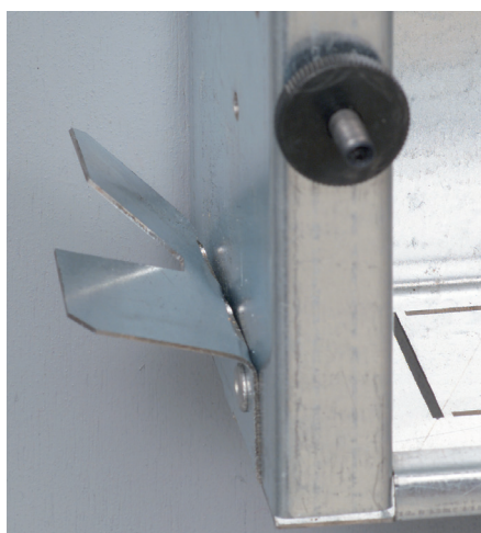
Relever les pattes de scellement
