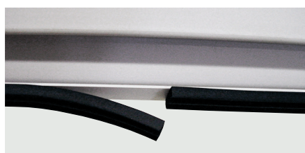
Le raccordement du joint doit être réalisé dans la partie basse de la porte
