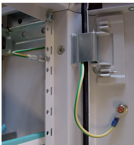
Le raccordement du joint doit être réalisé dans la partie basse de la porte
