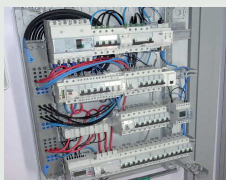
Coffret complet équipé de différents systèmes de répartition
