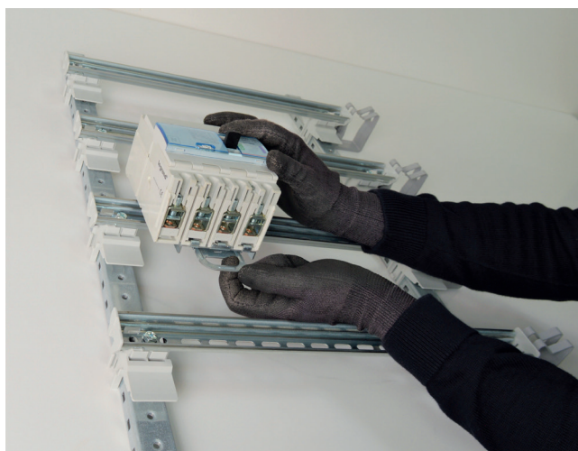
Montage de l'ensemble sur le châssis en retirant le support de rail plastique
