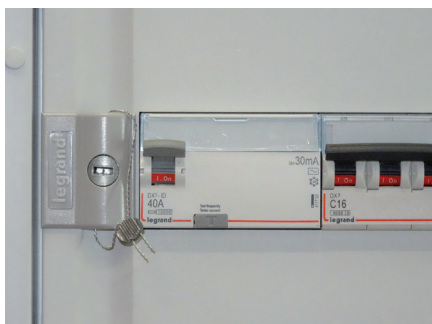
Plombage du plastron, en position verrouillée
