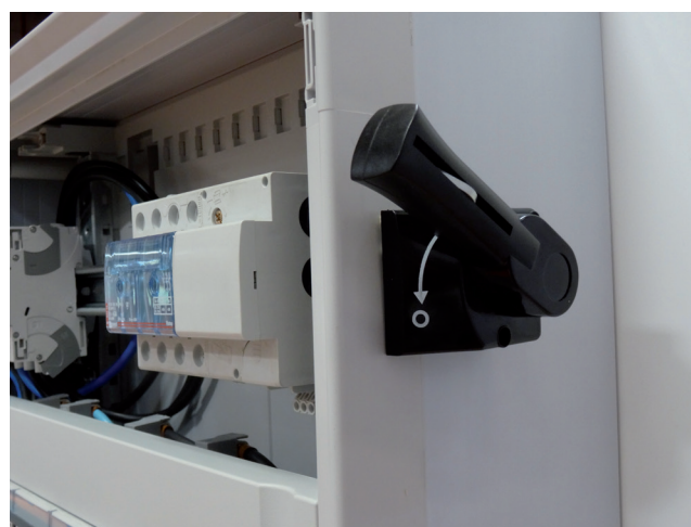
Un gabarit est fourni avec la commande latéral ou frontale pour le perçage du flanc
