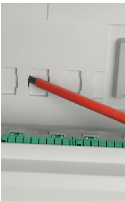
Défonçage des passages
